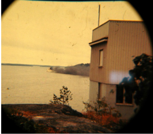
Norra gaveln av laboratoriet innan rivningen
